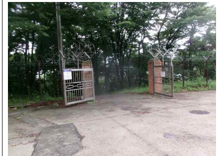
<진입로 포장 현황>
