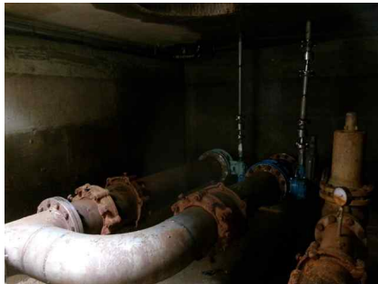
<유입밸브실 내부 전경>
