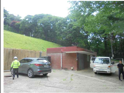
<전기실 외부 전경>
