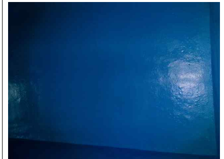
<2지 벽체 도장보수 현황>
