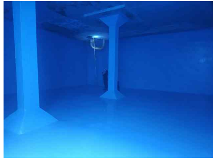
<내부 개별부재 외관조사>
