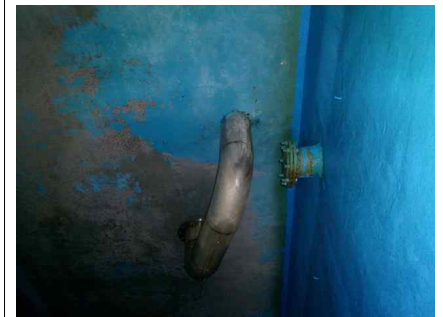
<2지 상부슬래브 백태>
