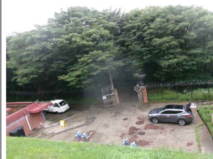
<배수지 상부 전경>
