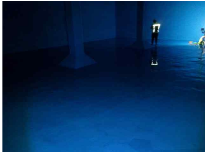
<내부 개별부재 외관조사>
